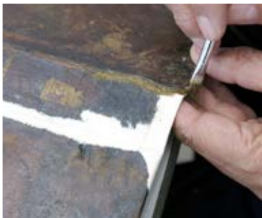
Foto 55. Vista de la parte externa del refuerzo
