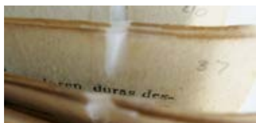
Foto 41. Detalle de reparaciones anteriores
